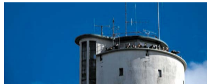
Der Turm wurde 1929 erbaut. Er diente ursprünglich als Wasserturm. Die Jugendherberge ist dort seit 1931 ansässig.
