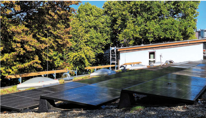
Energetische Sanierung des Kinderhauses Paradies: Auf dem Dach wurden Photovoltaikmodule installiert, die künftig zur klimafreundlichen Stromversorgung der Einrichtung beitragen.
