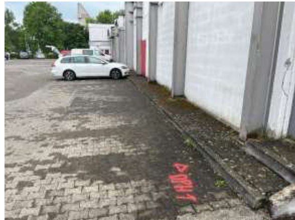
Abb. 2: Blick auf DPH 1/25 Richtung Südosten
