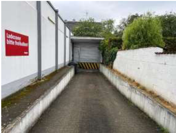
Abb. 1: Blick auf BK 1/25 Richtung Südwesten
