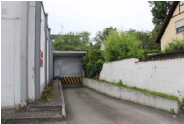
Ort der Warenlieferungen für den Lebensmittel-Discounter im Nordwesten des Plangebiets. Rechts im Bild: Angrenzendes Wohnhaus.
