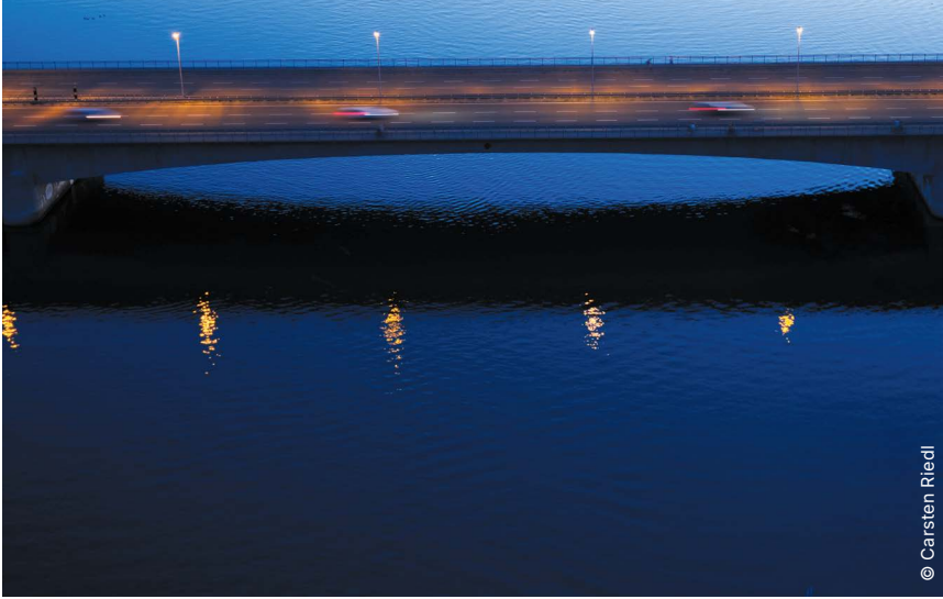
Da das intelligente LED-System exakt auf die Brücke ausgerichtet ist, fällt weniger Licht auf die Wasseroberfläche des Rheins, als bei herkömmlicher Beleuchtung.
