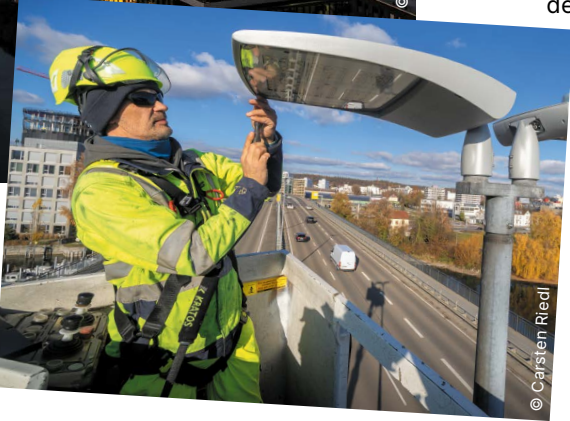
Anhand der Daten aus Verkehrs- und Wettersensoren wird die LED-Beleuchtung auf der Europabrücke dynamisch und nach Bedarf gesteuert.
