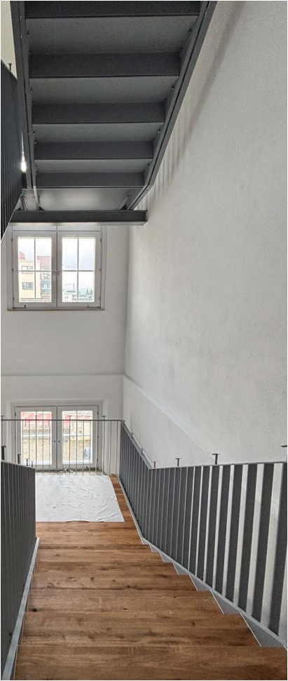
Die neue Brandschutz-Innentreppe in der Gemeinschaftsschule Lotte Eckener verbindet Sicherheit mit denkmalgeschützter konformer Gestaltung.
