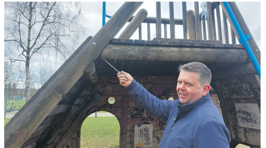
Carsten Petschkuhn von den Technischen Betriebe Konstanz (TBK) testet hier bei der Spielplatz-Jahreskontrolle die Holzverbindungen des Spielgeräts am Schänzle-Spielplatz auf Fäulnis. Dazu sticht er mit einem Schraubenzieher in überlappende Holzteile.
