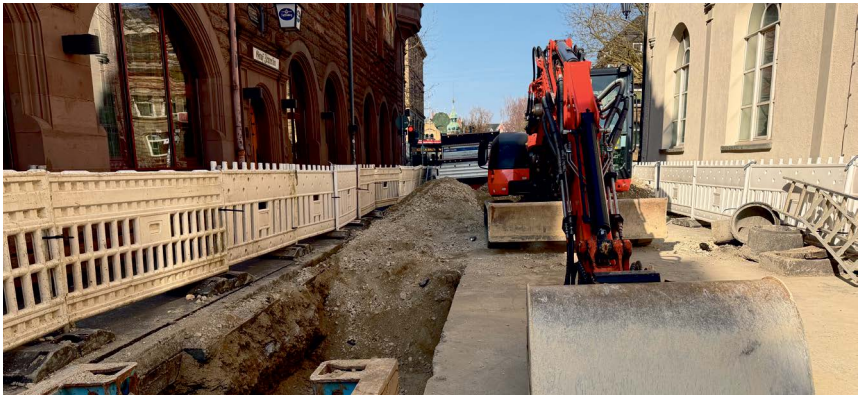
Die Kanalerneuerung in der Zufahrt zum St.-Stephans-Platz befindet sich schon im zweiten Bauabschnitt. Der Kreuzungsbereich Laube ist bereits fertiggestellt.
