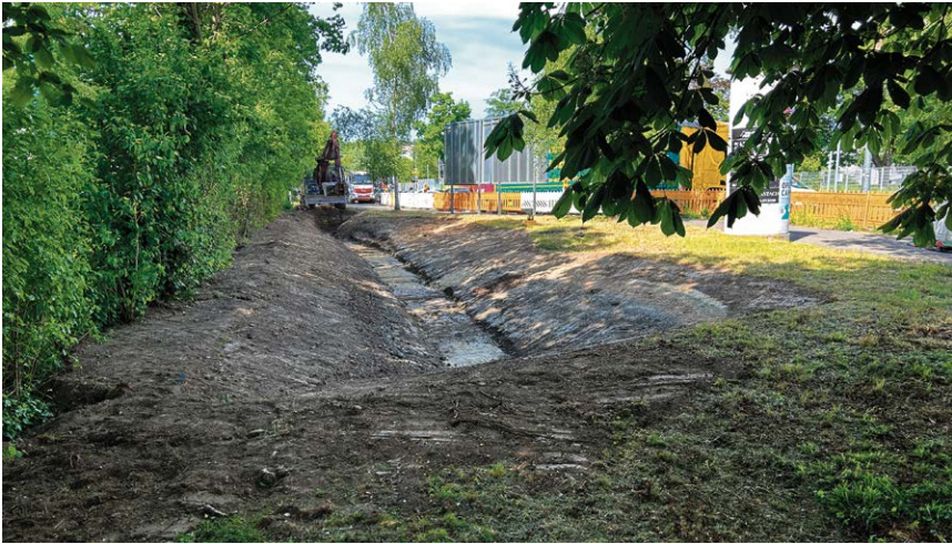
Im Mai 2025 wurde in der Oberlohnstraße eine neue Mulde hergestellt, in der Regenwasser versickern und verdunsten kann.
