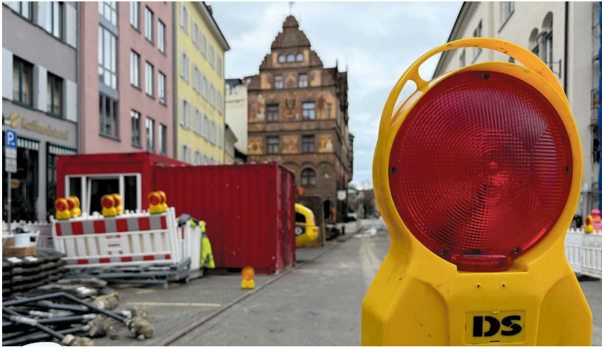
In der Zufahrt zum St.-Stephans-Platz erneuern die Entsorgungsbetriebe aktuell einen Kanal in offener Bauweise.
