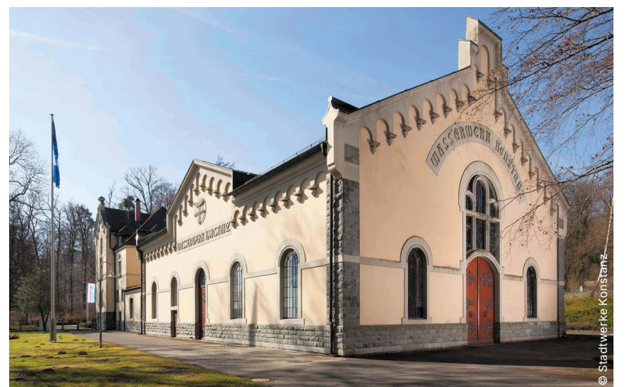
Strom statt Gas: Das Wasserwerk wird jetzt klimafreundlich mit Wärme versorgt.
