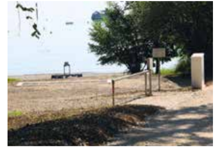
Die Anlage siebt Schmutz aus dem Wasser.
