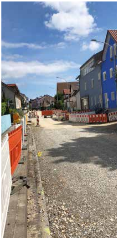
Sanierung der Fürstenbergstraße
