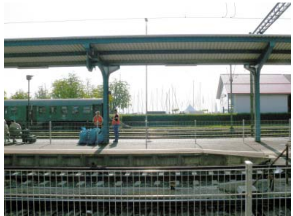
Blick zum See zwischen Hafenhalle und Spie- gelhalle
