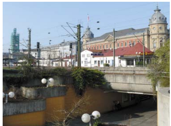
Marktstättenunterführung Richtung Stadt
