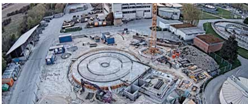
Blick von oben auf die frisch betonierete Bodenplatte am 20.04.2021
