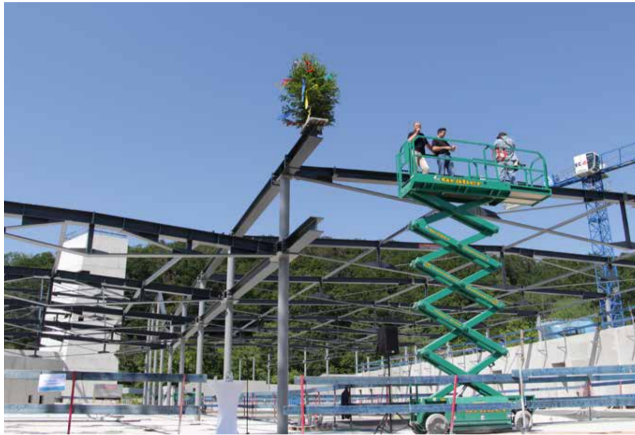
Handwerker beim Richtspruch für das neue Schwaketenbad. Im Hintergrund ist der Rutschenturm zu sehen. Links vorne entsteht der Kinderbereich und rechts das Nichtschwimmerbecken sowie dahinter eines der 25-Meter-Schwimmerbecken.
