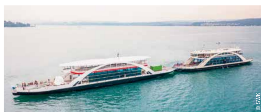
LNG-Fähre: Die neue mit Gas betriebene Fähre der Stadtwerke (links im Bild) ist im Rohbau fertig. Der weitere Ausbau findet auf dem Fähre-Gelände in Staad statt. Das Schiff wurde am 26. Juni von der Werft in Österreich an ihren künftigen Heimathafen Staad geschleppt.
