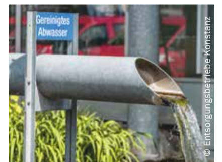
Gereinigtes Abwasser aus der Konstanzer Kläranlage
