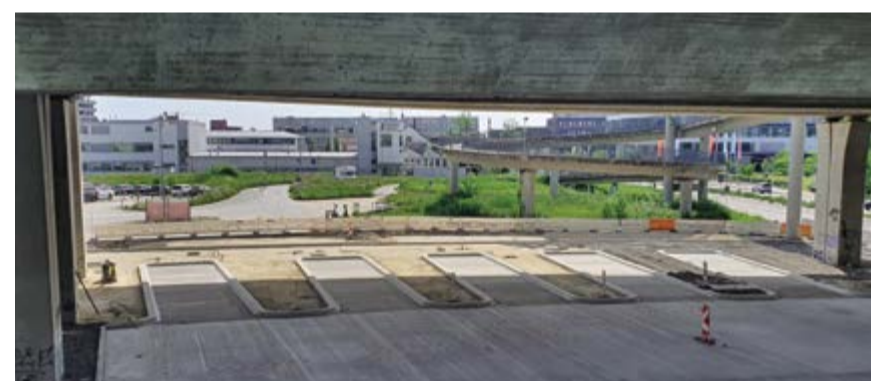
Der Fernbusbahnhof an der Europabrücke wird im ersten Quartal 2024 fertiggestellt.
