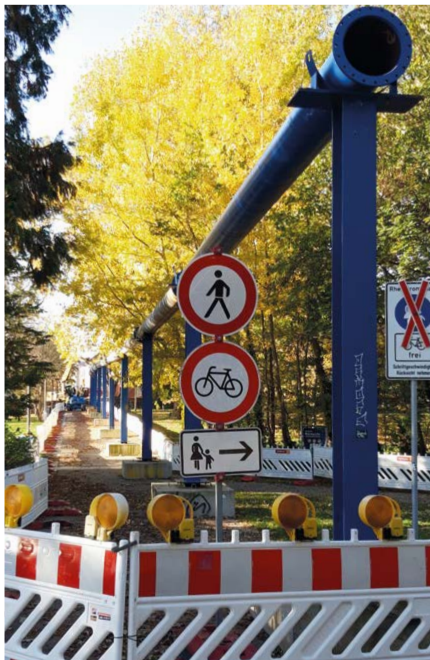
Zu den vorbereitenden Maßnahmen für die Kanalsanierung gehören diese blauen Rohre am Herosé entlang des Seerheins. Über diese wird während der Sanierung das Abwasser geleitet.
