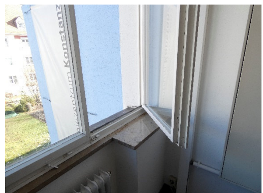
Abbildung 80 – Geb. E, Holz-Verbundfenster
