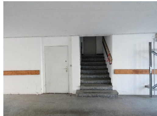
Abbildung 82 – Geb. E, Zugang Durchfahrt
