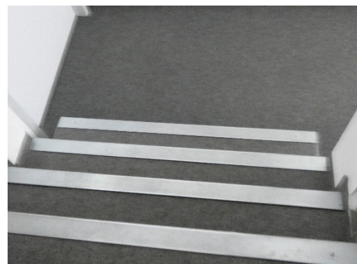
Abbildung 83 – Geb. E, Durchgang Geb. C2 zu Geb. E
