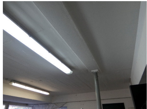
Abbildung 79 – Decken mit Stahlunterzug und Rundrohrstützen
