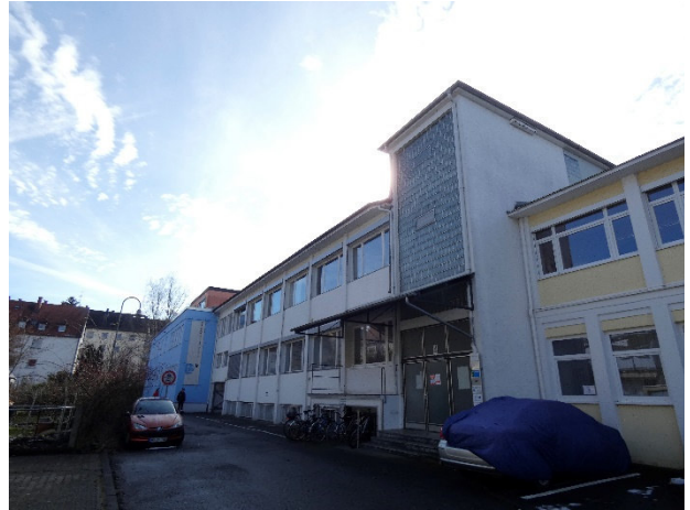
Abbildung 77 – Geb E, Ansicht Nordost
