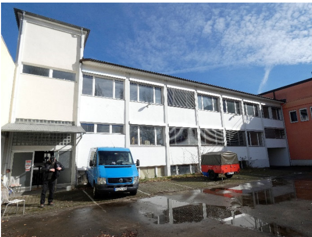
Abbildung 78 – Geb E, Ansicht Südwest
