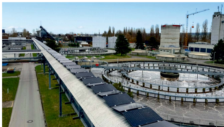
Das lange Dach der Medienbrücke wurde mit 322 PV-Modulen bestückt.
