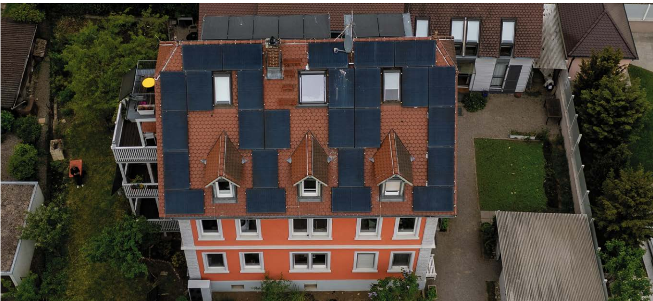
Die Stadt hat im Rahmen der Leuchtturmförderung die Installation einer Photovoltaikanlage auf dem Dach des Gebäudes in der Hoheneggstraße 17 gefördert.
