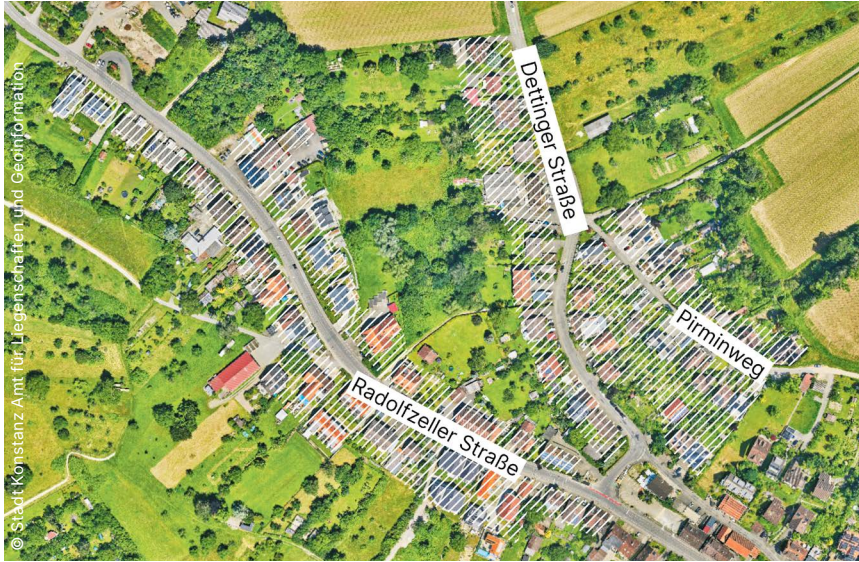
An privaten Gebäuden entlang der Dettinger Straße, der Radolfzeller Straße und des Pirminwegs (weiß schraffiert) sollen Höhlen- und Nischenbrüter-Kästen für Haussperlinge angebracht werden.
