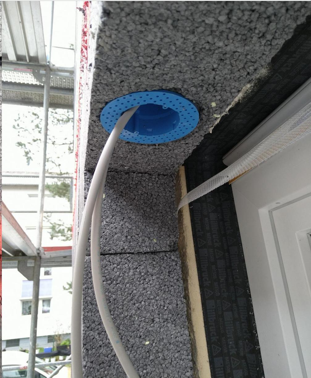
Kabel für Rollläden und Ablüfter sind in der Außendämmung verlegt
