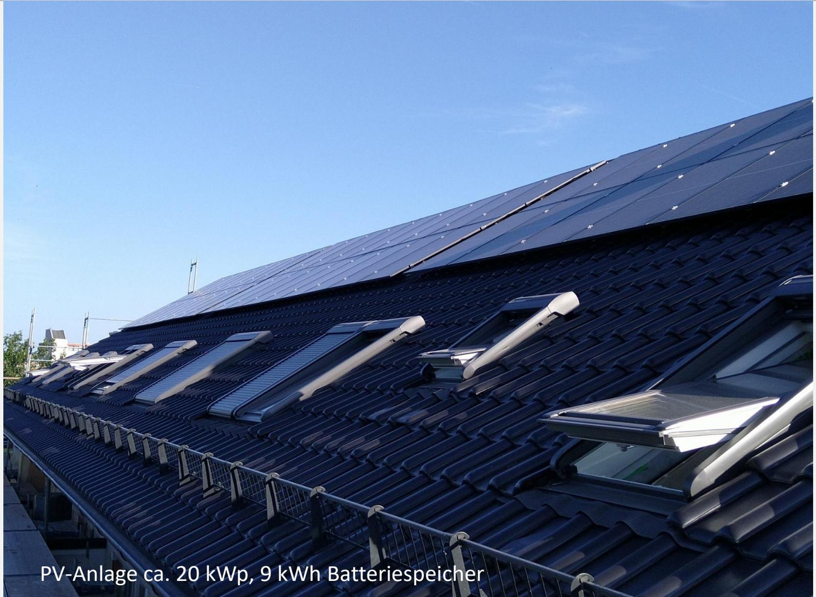
PV-Anlage ca. 20 kWp, 9 kWh Batteriespeicher
