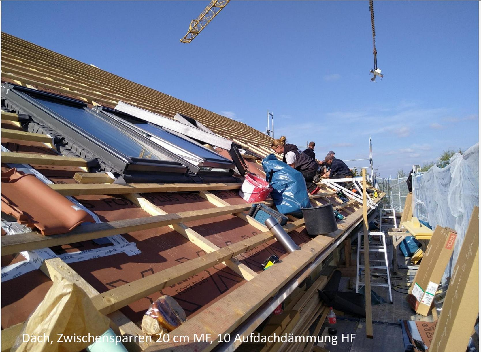
Dach, Zwischensparren 20 cm MF, 10 Aufdachdämmung HF
