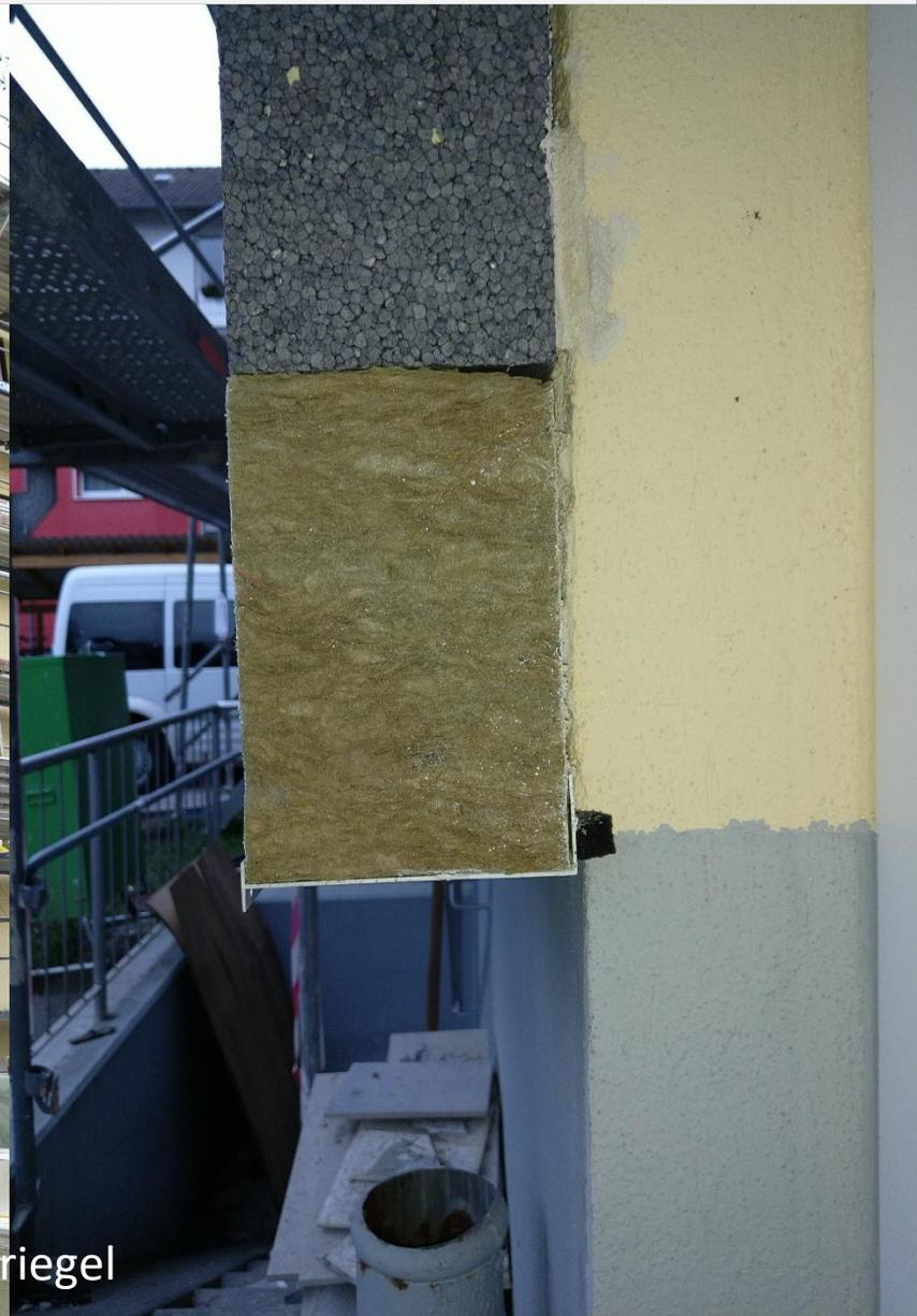
Außenwände, 14 cm PS-Dämmung mit Brandschutzriegel
