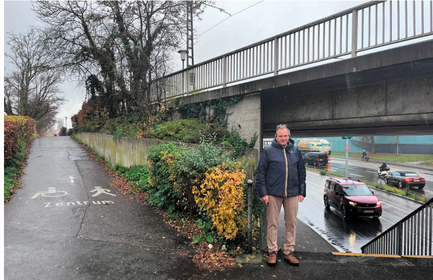
Michele Lagrutta, stellvertretender Leiter des Tiefbauamts, zeigt, wo die Bauarbeiten am Sternenplatz stattfinden. Die Arbeiten an der Gabelung Josef-Picard-Straße / Glärnischstraße dauern voraussichtlich bis Ende Juli 2026.
