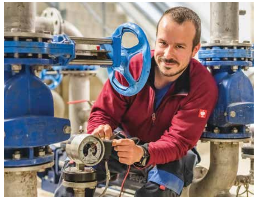
Kevin Hangarter bei seiner Arbeit als Elektriker auf der Kläranlage der EBK
