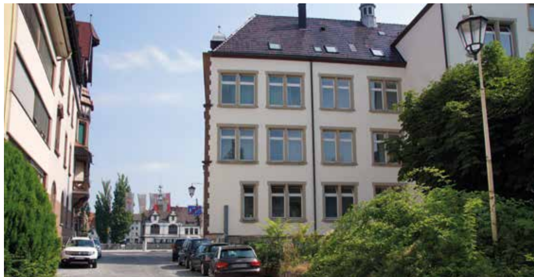
Die Radstadt Konstanz fährt nun auch via Schreiber-/Klostergasse zum Rheinsteig. Die alten Kettenabsperren an der Straße sind seit dem Umbau des Rheinsteigs weg und es gibt einen neuen Übergang mit abgesenktem Bordstein. Also freie Fahrt!
