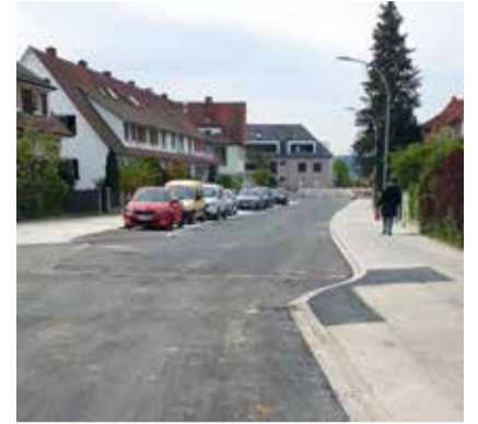
Die Baumaßnahmen im Taborweg sind nun abgeschlossen.
