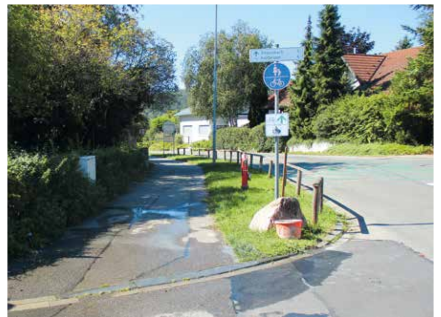
Neu abgeschliffener Randstein in der Allensbacher Straße
