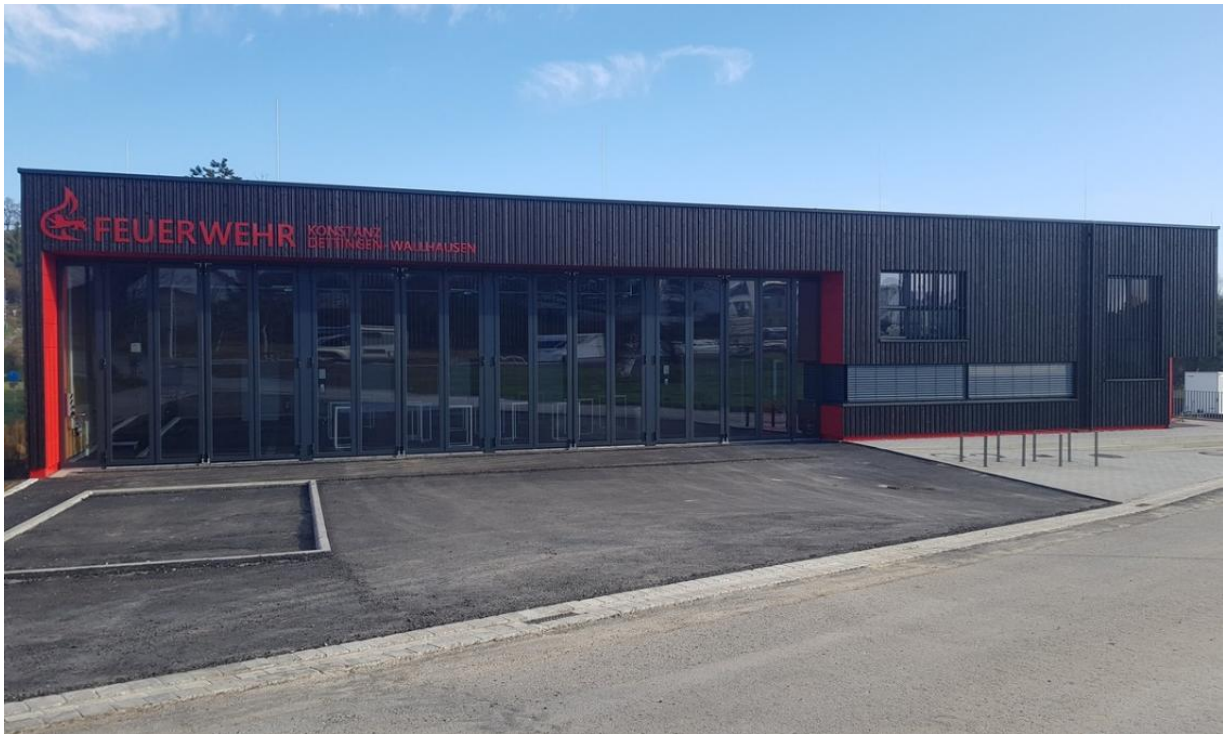
Abbildung 23: Neubau Feuerwehr Dettingen
