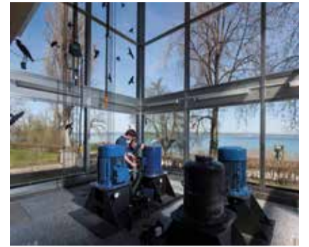
Rohwasser-Pumpen Wasserwerk
