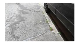
In der Richentalstraße bei der Einmündung in die Gottlieber Straße, Hausnummer 36, ist durch die Neugestaltung der Oberfläche eine Schwelle entstanden, die zu einer Stolperstelle werden kann.
