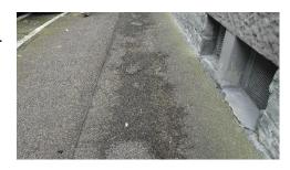
In der Tägermoosstraße – Blarerstraße ist der Übergang an der Bordsteinkante durch eine tiefliegende Dole für Rollator-Benutzer und Rollstuhlfahrer schwer zu überwinden. Die Schlitze im Dolendeckel bergen die Gefahr, dass die Räder von Kinderwagen und Rollatoren darin versinken.
