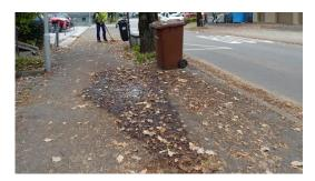
Baumwurzeln bei Brüelstraße 26 haben die Gehwegoberfläche angehoben. Dadurch kann eine Stolperstelle entstehen.
