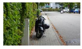
Vor Hausnummer 72 in der Gartenstraße fehlt an der Einmündung von der Feldstraße die Absenkung der Bordsteinkante. Der Übergang wird dadurch für Rollator-Benutzer und Rollstuhlfahrer erschwert.
