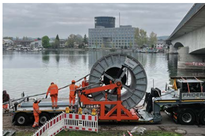
Mittels einer Seilwinde wird das Stromkabel durch die Erde gezogen.
