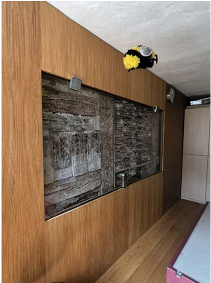
Die Räumlichkeiten der Kleinkindbetreuung „Hummelbande“ wurden umfassend vom Hochbauamt saniert und neugestaltet. In eine Wand wurde ein „Zeitfenster“ eingesetzt, das den Aufbau der historischen Wände zeigt.
