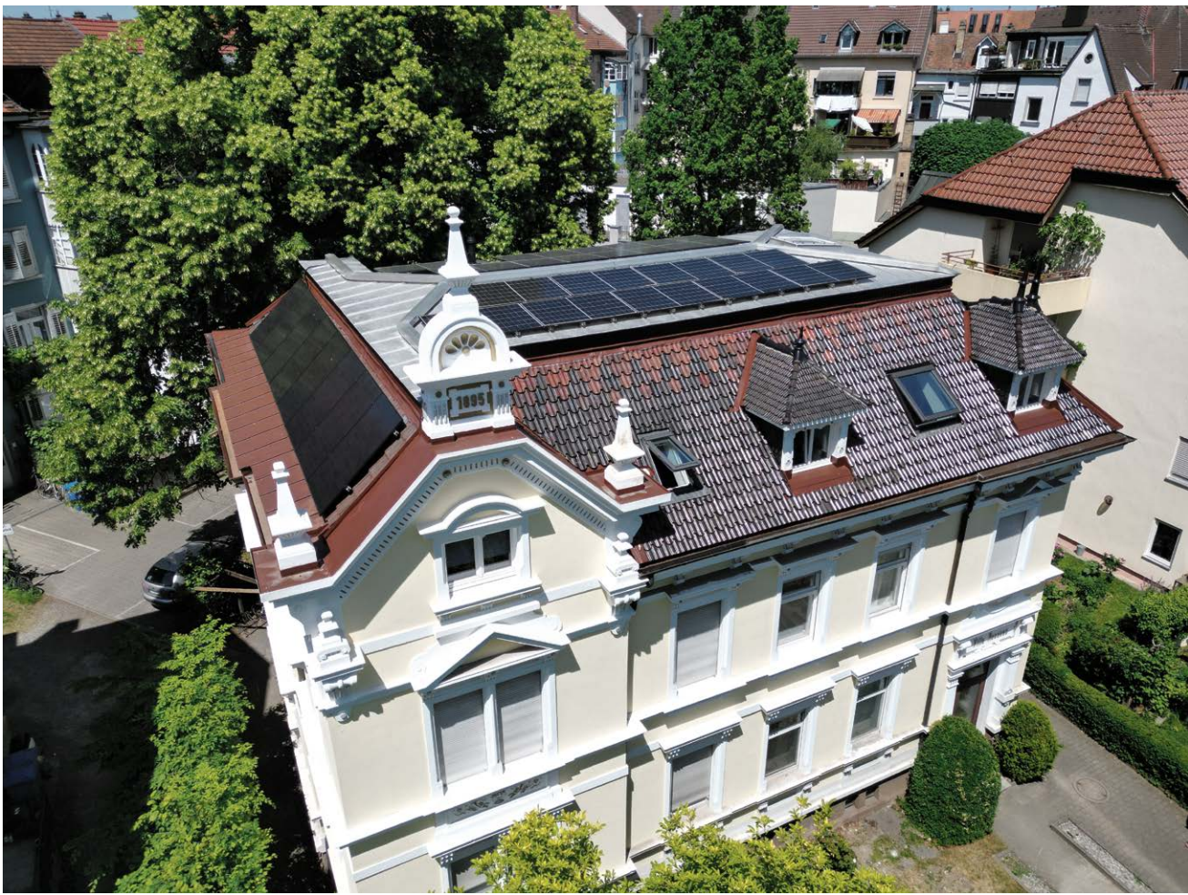
Nur von oben zu erkennen: Die Villa Rosenau wird mit Strom aus der Photovoltaikanlage auf dem Dach versorgt.
