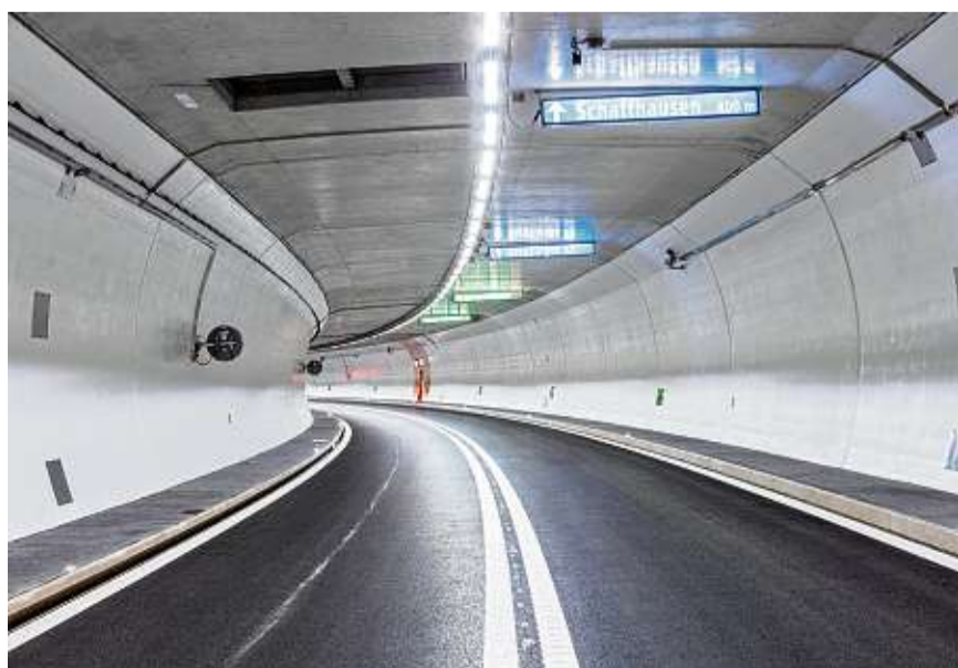
So sah es Mitte November im Galgenbucktunnel aus, der am 6. Dezember 2019 für den Verkehr freigegeben wurde. Am 24. November konnten Besucher hier eine Tunnelwanderung unternehmen.
