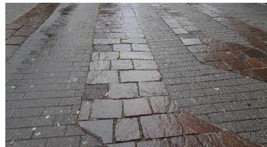
Zum Überqueren des Zähringerplatzes muss auch der Radweg überquert werden. Die Kanten am Radweg sind nicht abgesenkt.
