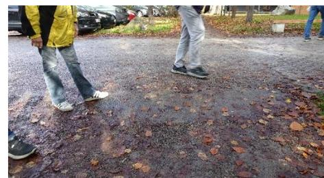
Im weiteren Verlauf des Gehwegs in der Luisenstraße ist die Oberfläche durch Wurzeln uneben und kann zu Stolperstelle führen.
