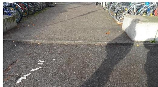
Der Überweg ist auf der Seite des Einkaufszentrums abgesenkt. Auf der anderen Seite endet er am Bussteig mit einer erhöhten Bordsteinkante.
