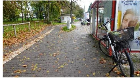
Für die mit groben Pflastersteine belegten Flächen am Ampelübergang benötigen Rollator Benutzer mehr Kraft. Es besteht eine höhere Sturzgefahr.
