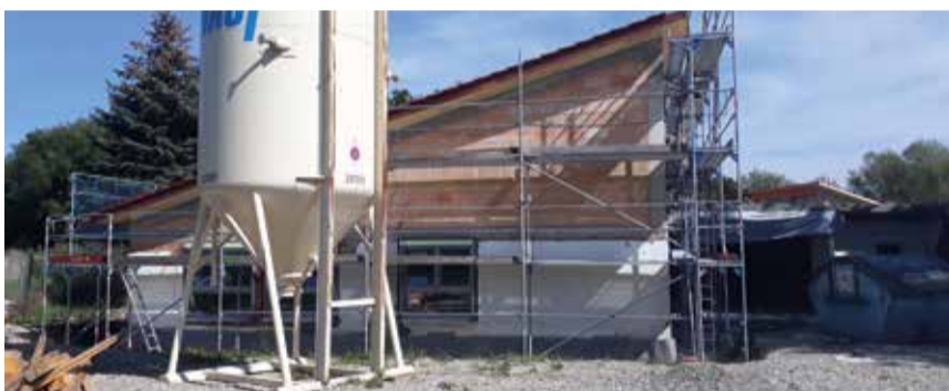
Baustelle beim Kindergarten St. Martin in Wollmatingen
