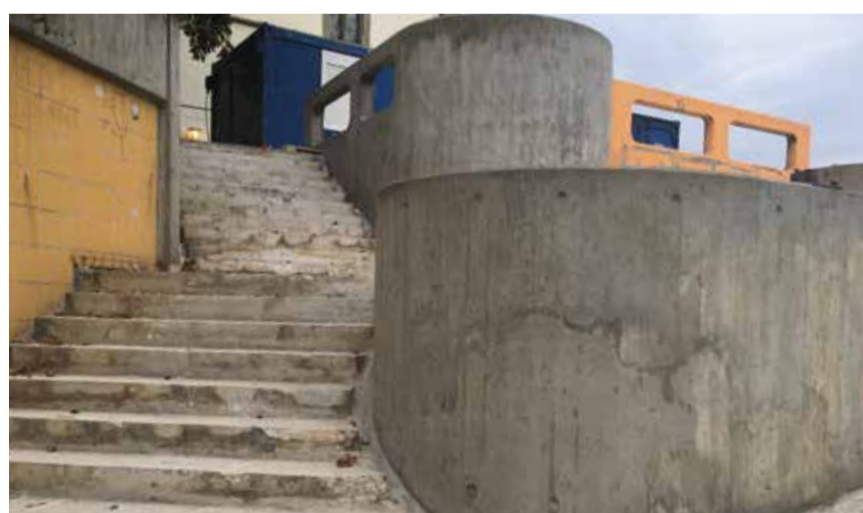
Neue Sitzstufen an der Marktstätte-Unterführung: Anfang September haben die Arbeiter der TBK in der Unterführung zur Marktstätte begonnen. Die Treppenstufen werden angelehnt an die Stufen vor dem Pano gestaltet, jedoch mit einzelnen eingelassenen Holz-Sitzelementen (diese werden im Herbst auch vor dem Pano ergänzt). Die Arbeiten sollen Ende November fertiggestellt sein. Damit bieten 2019 beide der Sonne zugewandten Treppen höhere Aufenthaltsqualität. Im Frühjahr werden die Stufen auf der anderen Seite gerichtet.
