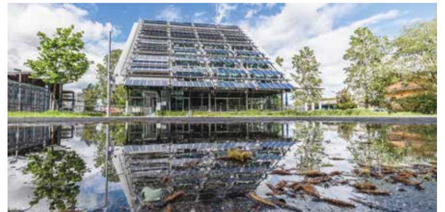
Das Dach des Betriebsgebäudes macht deutlich: Die EBK bauen auf erneuerbare Energien.
