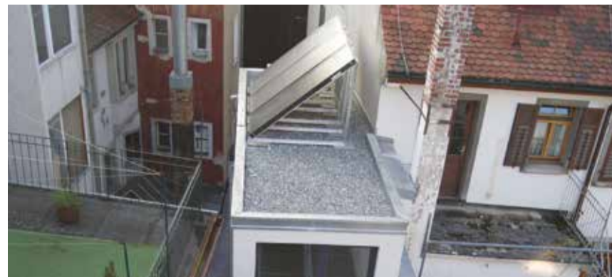
Moderne Hofbebauung mit Solarthermieanlage in der Wessenbergstraße 37
