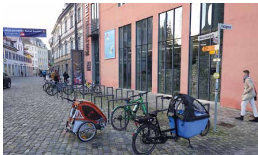
Radabstellanlage am Münsterplatz: Die bestehende Anlage vor dem Kulturzentrum hatte 20 Fahrradstellplätze. Sie wurde nun um 12 Anlehnbügel für 24 Fahrräder ergänzt. Insbesondere im Sommer besteht an dieser Stelle ein großer Bedarf zum Fahrradparken. Die Anlage wird vorwiegend aus dem Handlungsprogramm Rad finanziert. Der Ausbau von Radabstellanlagen mit Anlehnbügeln in der Altstadt ist damit vorerst abgeschlossen. Nach Erhalt der Zuwendungsbescheide geht es mit den Abstellanlagen im Bereich Bahnhof, Hafen und Katamaran weiter.
