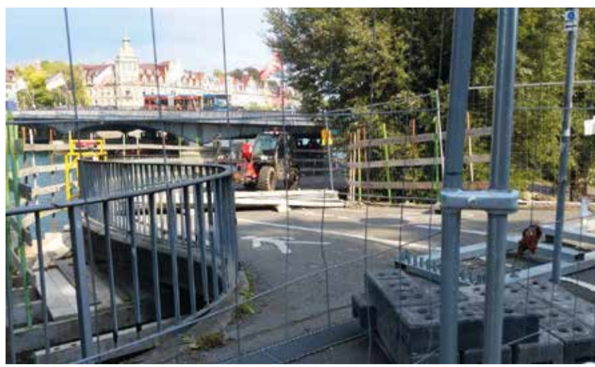
Baustellen-Einblick: Die Fahrradspindel am Bärengraben wird saniert.
