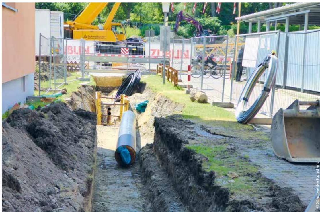
Bau der Nahwärmenetz-Leitungen am Pfeiferhölzle. Die WOBAK und die Stadtwerke haben für die dortigen Neubauten ein Nahwärmenetz realisiert, das rund 600 Wohneinheiten mit Wärme versorgt.
