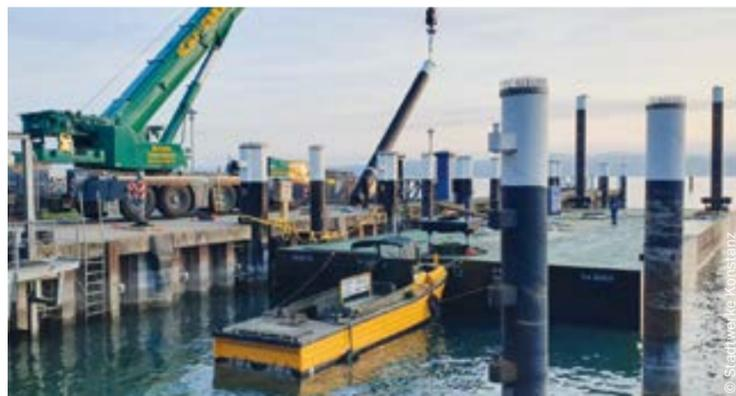
Ein Ponton wird den 90 Tonnen schweren Bagger samt Bohrgerät bei den Bauarbeiten im Fährhafen Meersburg tragen.
