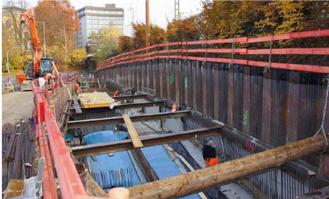
Die Arbeiten zum Bau der Rampe für einen barrierefreien Zugang zur Bushaltestelle am Sternenplatz Ost sind in vollem Gange. Das Bild zeigt die Spundwand zur Abstützung des Bahndamms.
