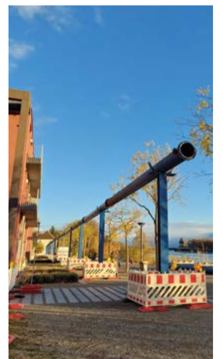
Anfang November stand bereits der erste Abschnitt der knapp 1 km langen, oberirdischen Abwasserleitung.
