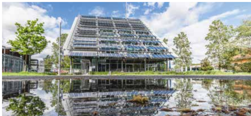
Betriebsgebäude der EBK. Zwischen Mai 2018 und Februar 2019 wurde die Südfassade saniert. Auf dem 45° schrägen Dach wurde die Verglasung ausgetauscht, der Sonnenschutz erneuert und eine neue, leistungsstärkere Photovoltaikanlage montiert.
